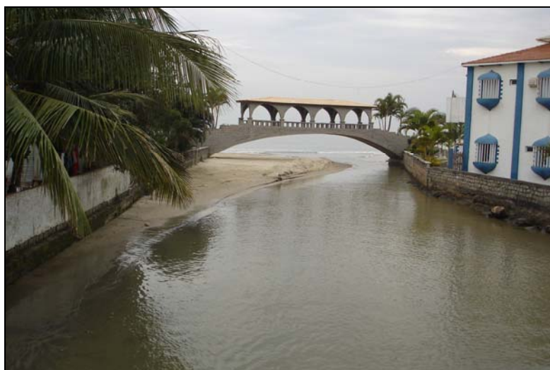
Figura 113 - Ponte dos Suspiros. Fonte: Pempti (2006).
