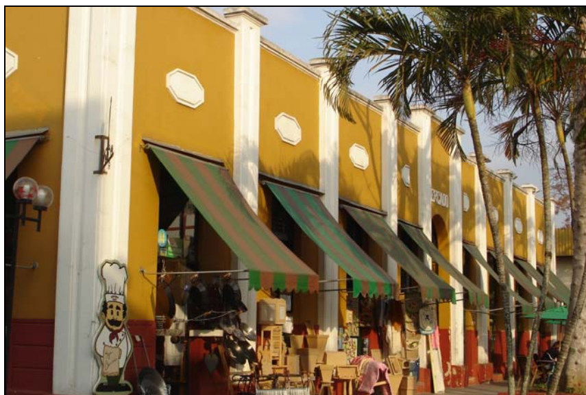
Figura 108 - Vista parcial do Mercado Público de Itajaí. Fonte: Penti (2006).
