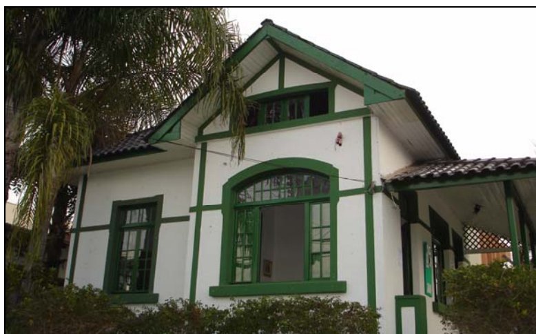
Figura 114 - Casa no pátio da Sede da Prefeitura de Itapema.
