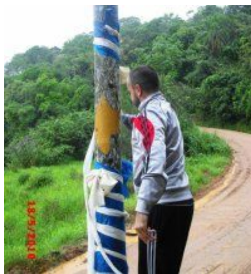
Manutenção da sinalização pela ACBC
